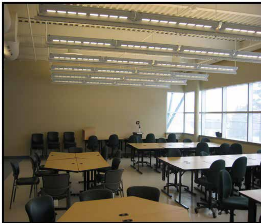
Acier apparent non protégé dans un ensemble plancher-plafond de salle de classe du Collège communautaire de la Nouvelle-Écosse et de l'école secondaire Citadel High School.
