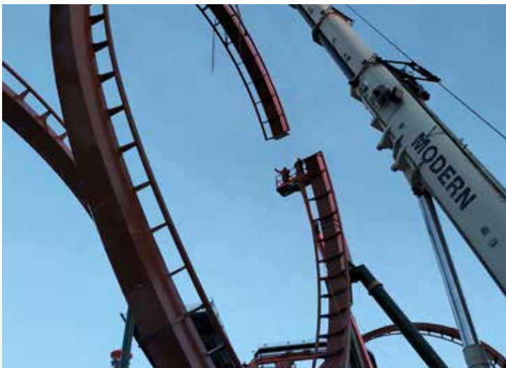
Les monteurs de charpentes métalliques guident le dernier élément de piste en place pour une boucle à 360 degrés.
