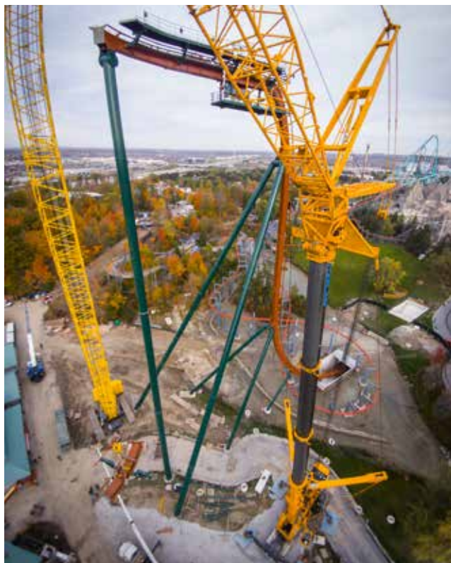
Vue en plongée de deux grues levant des rails à des hauteurs record.
