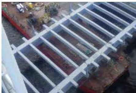
FIGURES 10 ET 11 : Positionnement de la travée levante
