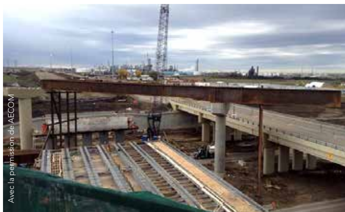
FIGURE 5 : Montage des poutres du pont 23.5 (pilier 1 à pilier 2)
