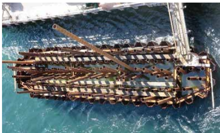
FIGURE 17 : Pieux tubulaires aux fondations des piliers
