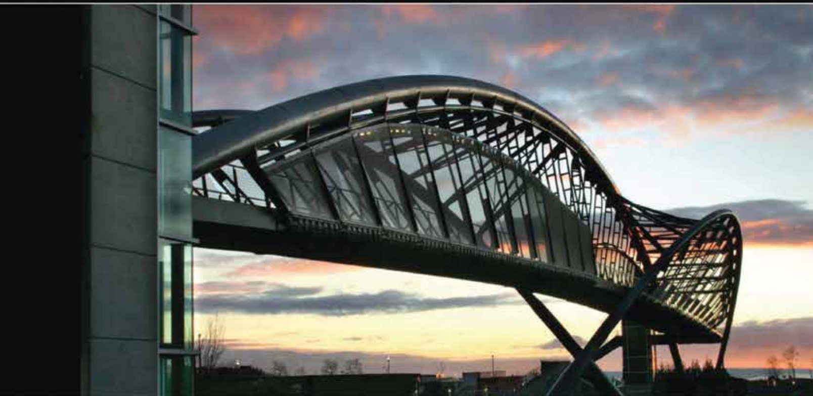
Pont hélicoïdal de Seattle Washington – 36 po (DE) x 1,25 po (paroi) et 24 po (DE) x 1 po (paroi) avec cintrage en hélice selon plusieurs rayons de courbure
