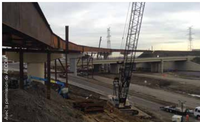
FIGURE 6 : Montage des poutres du pont 23.5 terminé (pilier 4 à culée 1)
