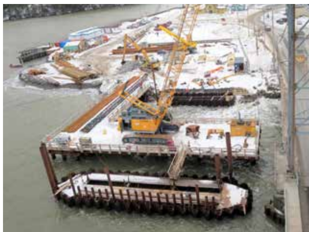
FIGURE 16 : Fondations profondes avec pieux en H
