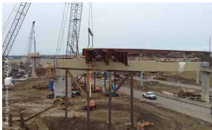
FIGURE 4 : Montage des poutres du pont 23.3 (pilier 5 à culée 1)
