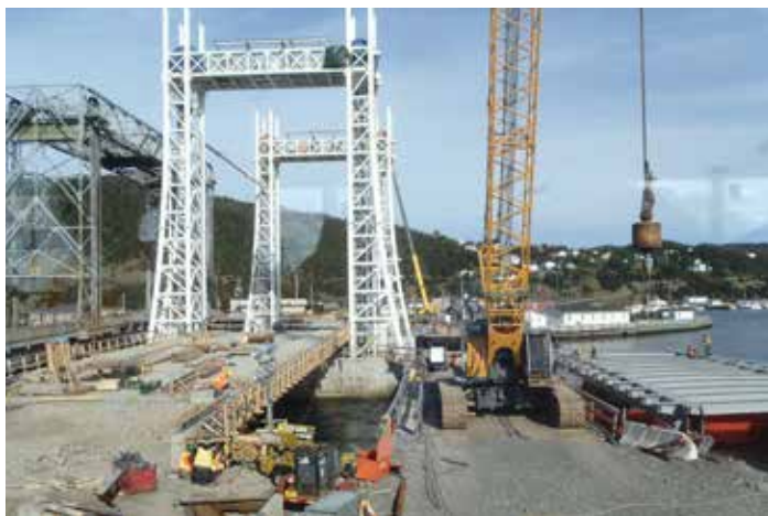
FIGURES 5 ET 6 : Montage avec une grue depuis un pont temporaire sur chevalets
