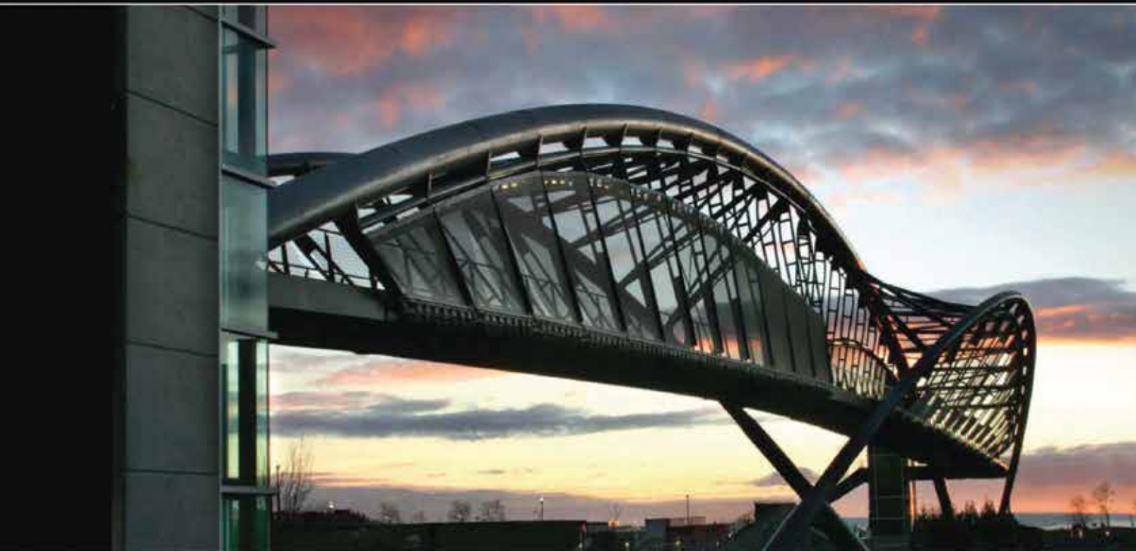
Pont héliçoïdal de Seattle Washington – 36 po (DE) x 1,25 po (paroi) et 24 po (DE) x 1 po (paroi) avec cintrage en hélice selon plusieurs rayons de courbure
